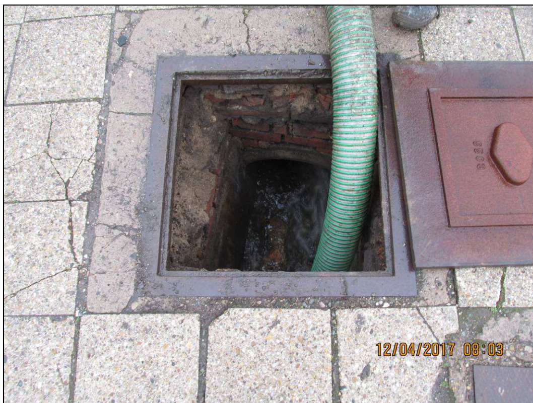
Obr. č. 13 - nálevná zkouška pro ověření vyústění odtoků z odvodňovacího žlabu
