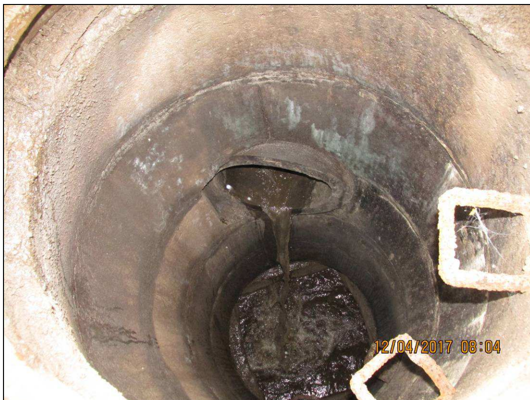
Obr. č. 14 - pohled do šachty Š5 směrem k šachtě Š4 - zaústění odvodnění přejezdu do kanalizace MěVak Jaroměř s.r.o.
