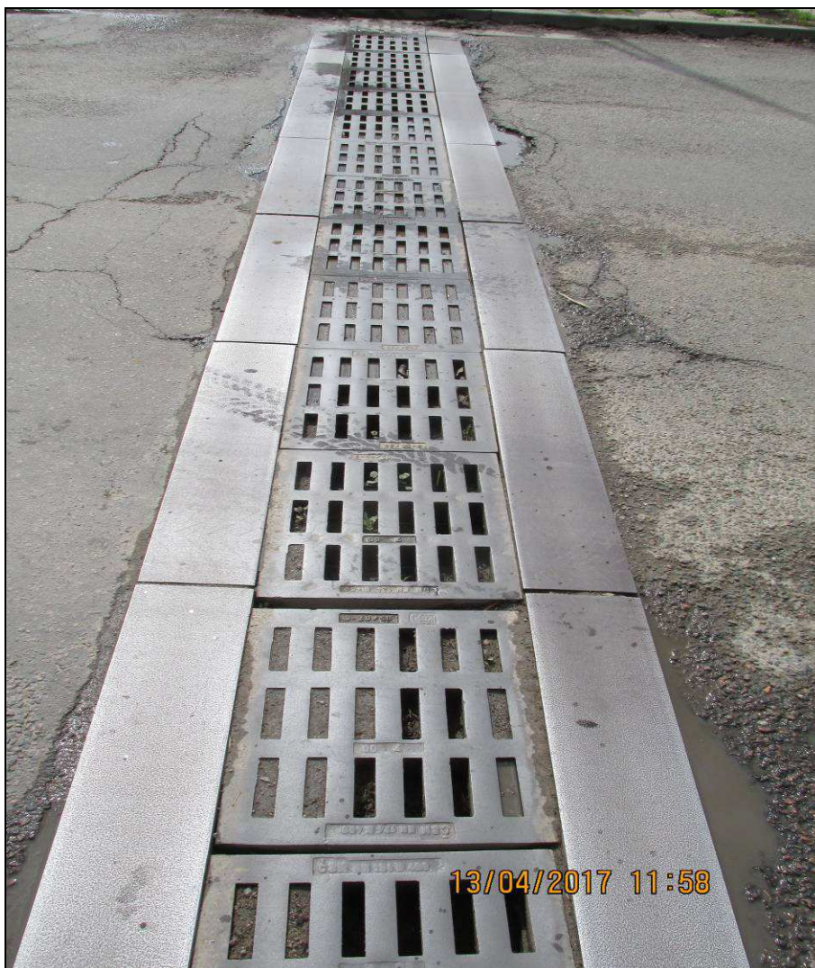
Obr. č. 1 - ocelové mříže odvodňovacího žlabu umístěného napříč silniční komunikací - odvodnění komunikace před železničním přejezdem směr Josefov
