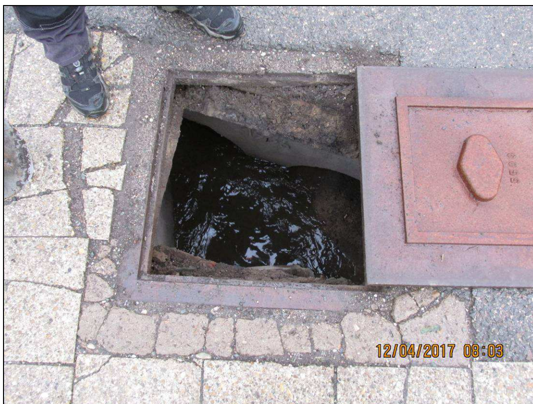
Obr. č. 8 - pohled do šachty Š3 směrem k šachtě Š4 - 2x trouba DN 500mm silně zanesená (cca z 70%)
