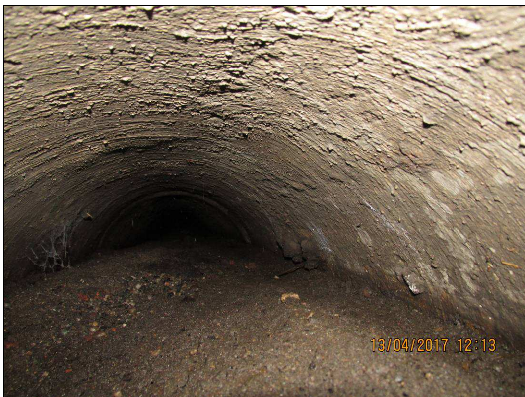
Obr. č. 9 - pohled ze šachty Š3 směrem k šachtě Š4 - z cca 70% zaneseno hlínou, pískem a štěrkem
