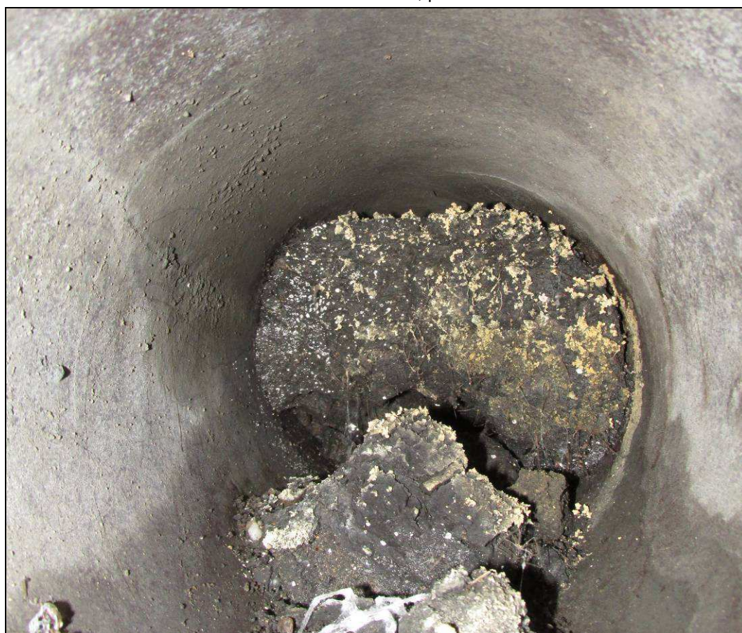
Obr. č. 10 - pohled ze šachty Š3 - zcela zanesený odtok ze silniční vpusti
